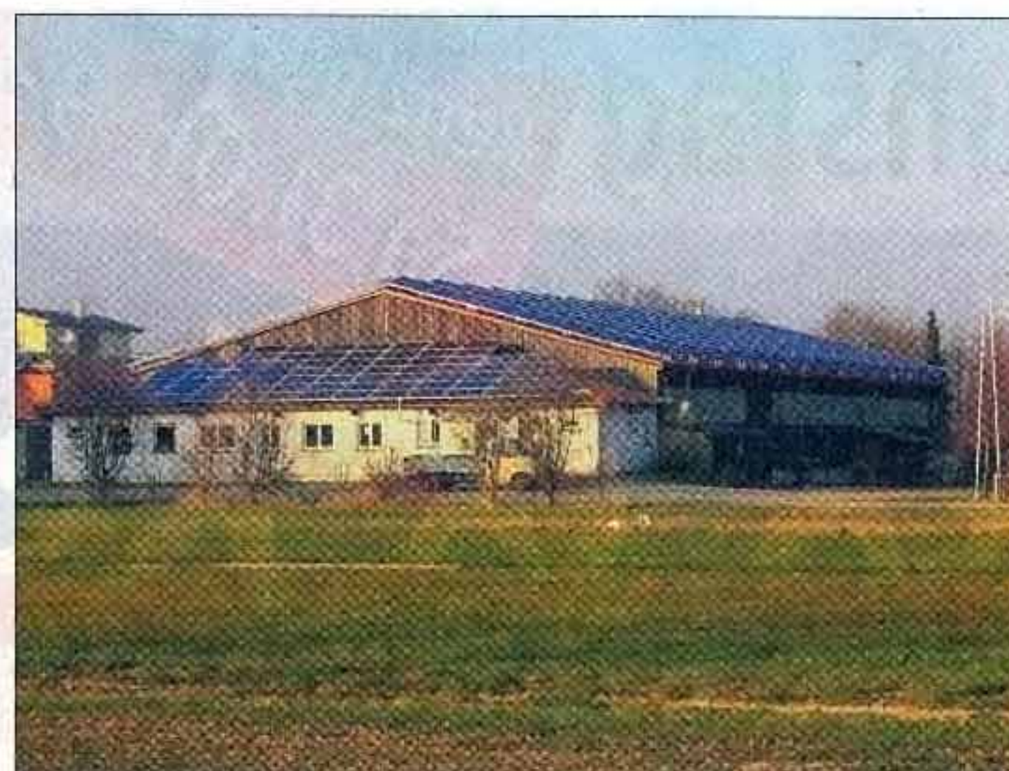
Das ganze Dach eine Solaranlage: Die Reithalle in Bahlingen.
