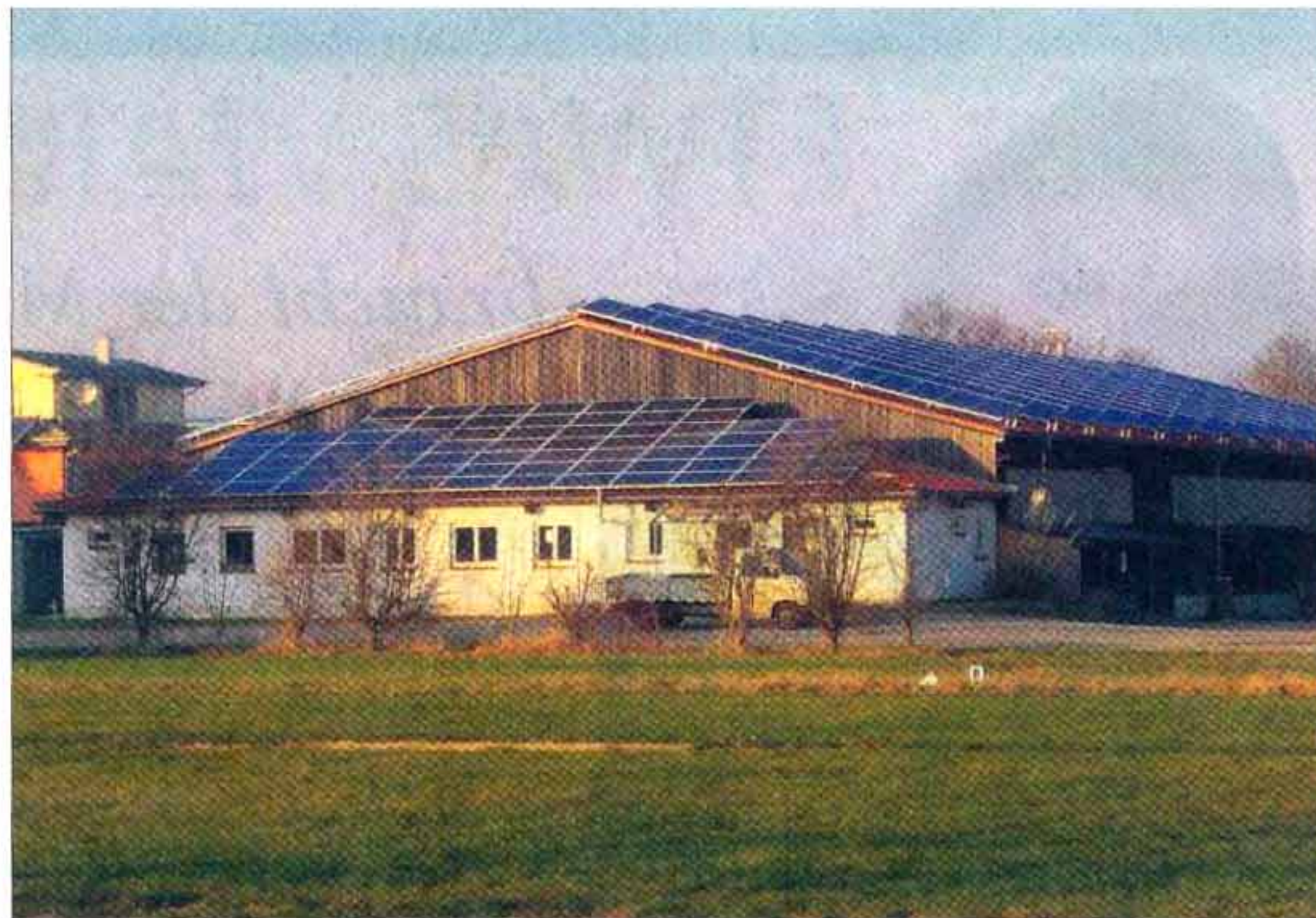
Das ganze Dach eine Solaranlage: Die Reithalle in Bahlingen.
